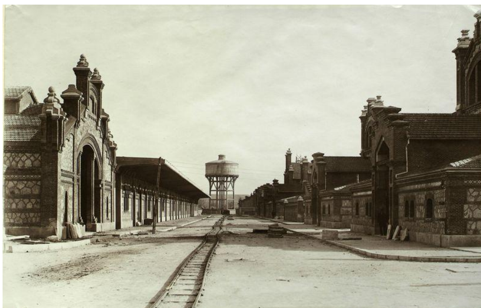
Imagen 3: Calle principal del Matadero Municipal.
